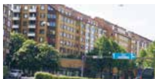
25 Brunnsgatan 1/Västergatan 11-15/ Övre Husargatan 6-12
