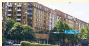
25 Brunngatan 1/Västergatan 11-15/ Övre Husargatan 6-12
