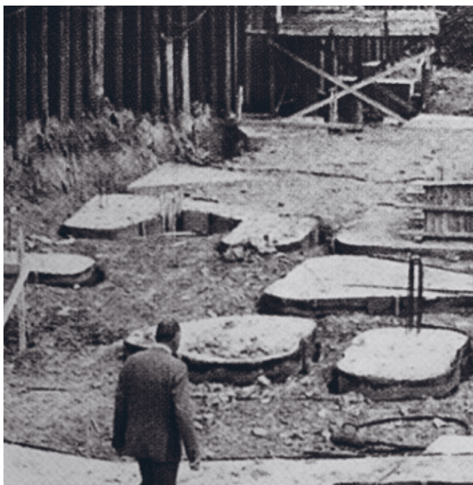
En av Bennys första byggplatser som ansvarig byggmästare, Ernst inspekterar.
